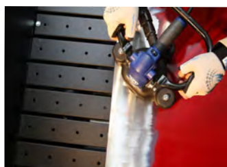
Eliminazione ossidazioni e vecchie vernici
